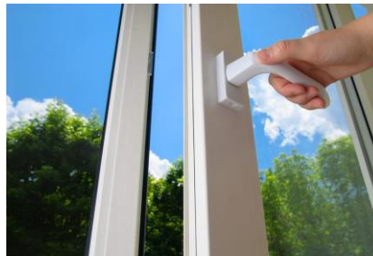
Vérification de l'opérabilité des fenêtres
