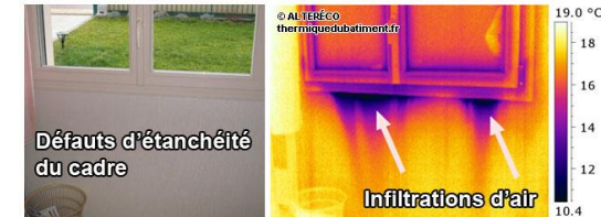
Observations sur l'étanchéité de l'enveloppe au niveau des ouvrants
