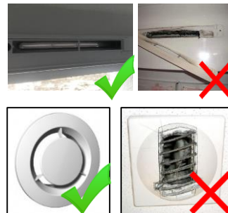
Recensement et examen des entrées d'air, des bouches de soufflage et d'extraction dans les locaux + relevé de débit de VMC
